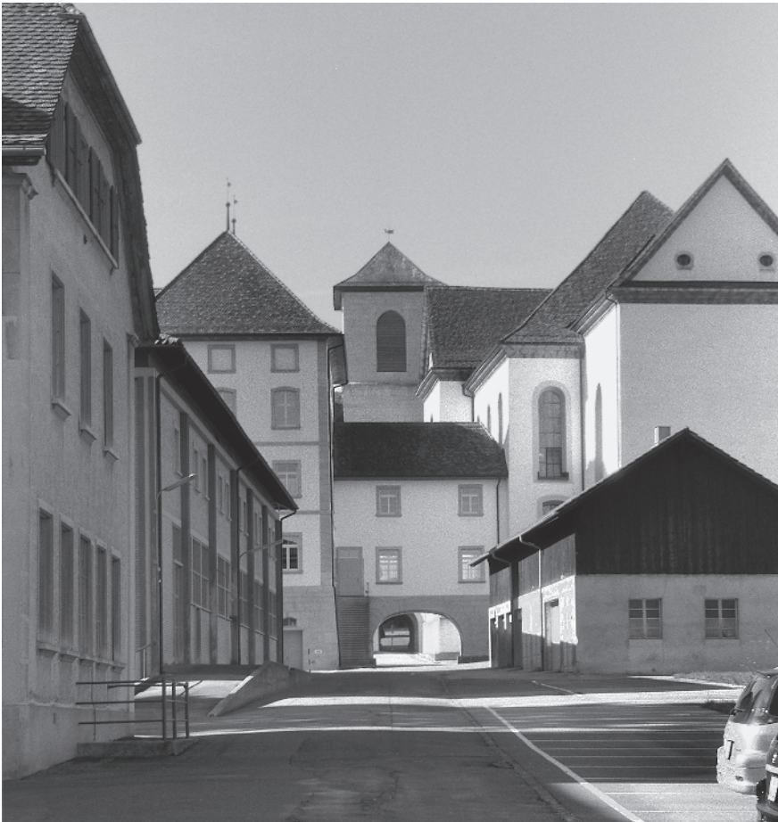
5 Cour des bâtiments annexes
